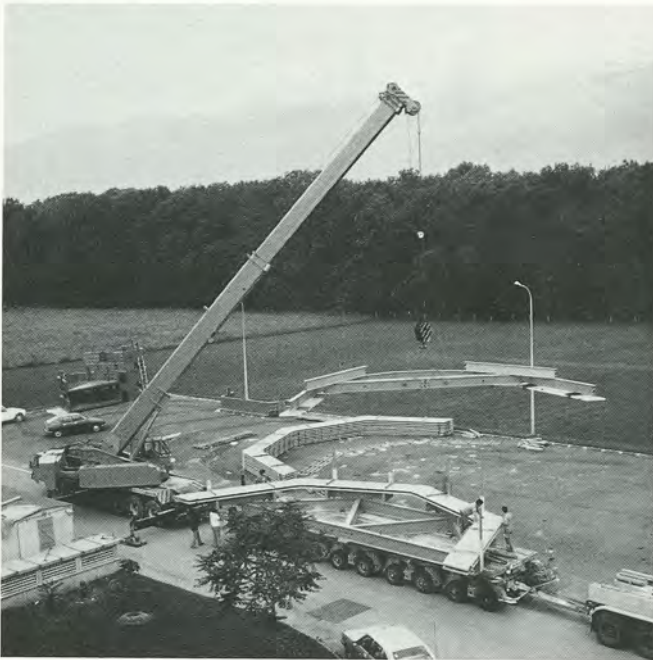
Manutention des demi-spires sur les zones de stockage extérieures.
